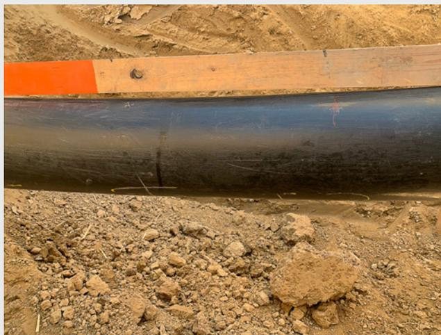
**Bild 7:** Rohrbogen im Nahbereich der Fehlstelle (beim roten Kreuz)
